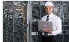
Sala de servidor tradicional
